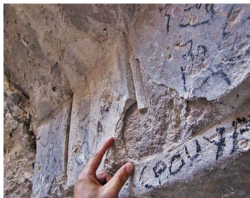
تصویر ۲۳. رد گیاه در ساختار ملات اندود ازاره تصویر ۲۴. لایه ملات بر روی سنگ در قسمت فضای ۷-۶ (نگارندگان، ۱۳۹۸). مقرنس (نگارندگان، ۱۳۹۸).
