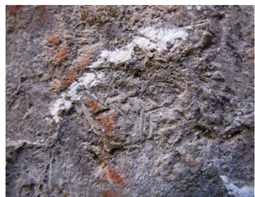
تصویر ۲۳. رد گیاه در ساختار ملات اندود ازاره تصویر ۲۴. لایه ملات بر روی سنگ در قسمت فضای ۷-۶ (نگارندگان، ۱۳۹۸). مقرنس (نگارندگان، ۱۳۹۸).
