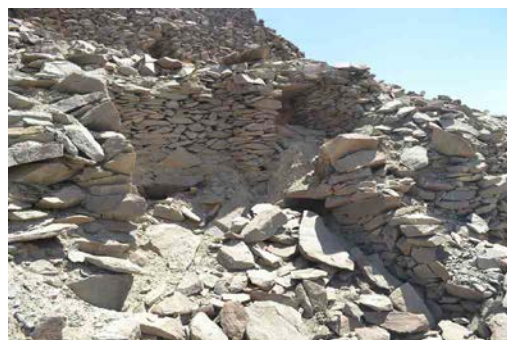
تصویر ۵. قسمتی از فضای سربازخانه که با استفاده از سنگ به صورت خشکه‌چین کار شده است (نگارندگان).
