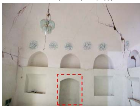
N-E ضلع شمال شرقی ورودی مسدود شده در دوره دوم معماری
