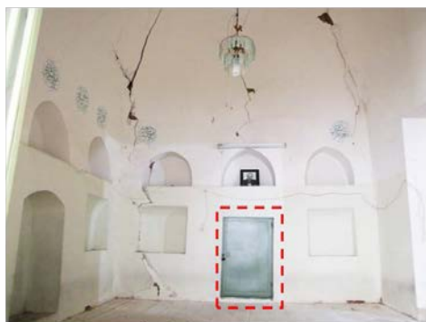
S-E ضلع جنوب شرقی ورودی مسدود شده در سال ۱۳۵۸
