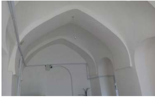
تصاویر ۹. نمایی از ستون‌های درگاه جنوبی و طاق ضربی قلعه جهانگیرآباد (نگارنده).
