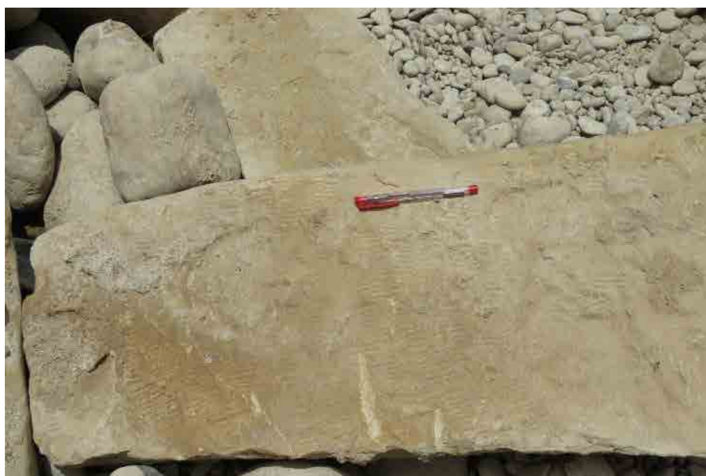
تصویر ۹: سنگ‌های تراش خورده و طرح‌های برشی جهت چسبندگی ملاط و جلوگیری از لغزش (نگارنده، ۱۳۹۵).
