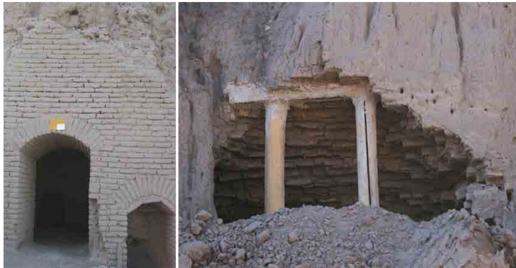
شکل ۹: راست: دستکندهایی در خشت‌های کهن در حصار داخلی ارگ؛ چپ: دستکندها با خشت‌های جدید مرمتی در حصار داخلی ارگ (نگارنده اول، ۱۳۹۵).
