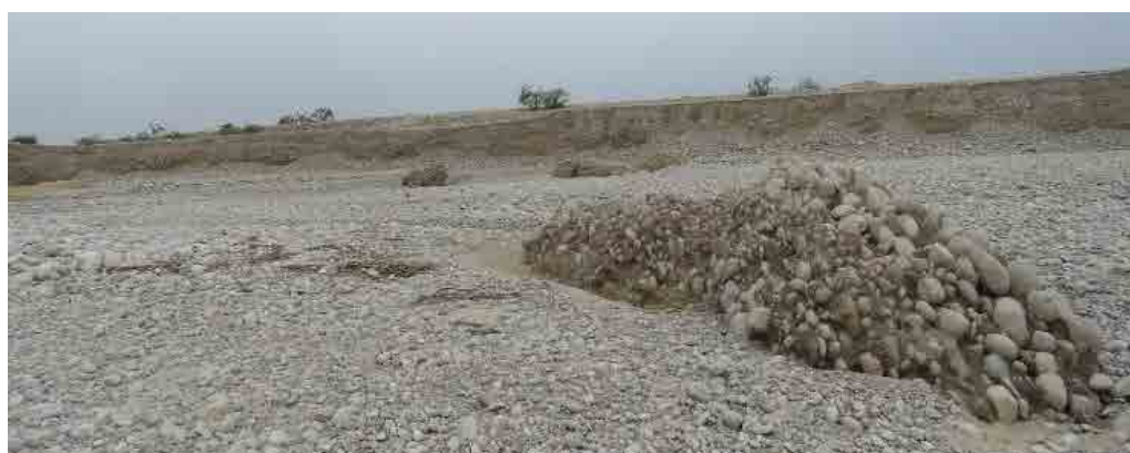
تصویر ۶: وضعیت بخشی از سازه از نمای غربی بستر رودخانه (نگارنده، ۱۳۹۵).
