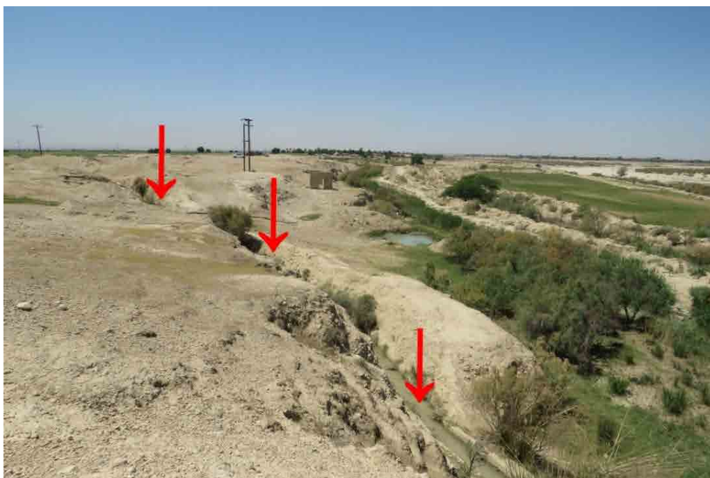
تصویر ۱۲: رشته قنات جوبجی با ورود به اراضی جوبجی از شکل تونل به کانال روباز تغییر شکل یافته است (نگارنده، ۱۴۰۴). Fig. 12: The Qanat of Jubaji has changed shape from a tunnel to an open channel as it enters the lands of Jubaji (Author, 2025).
