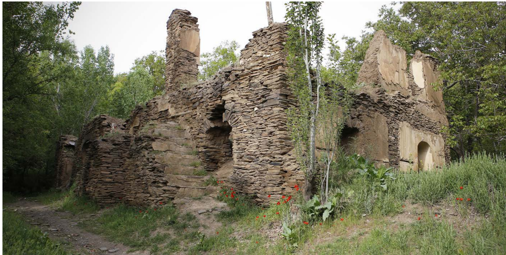
تصویر ۶. نمایی از بقایای خانه اربابی ورکانه (نمای اصلی بنا، ضلع شرقی)، (عکس از: محمد بلالی، ۱۳۹۴).
