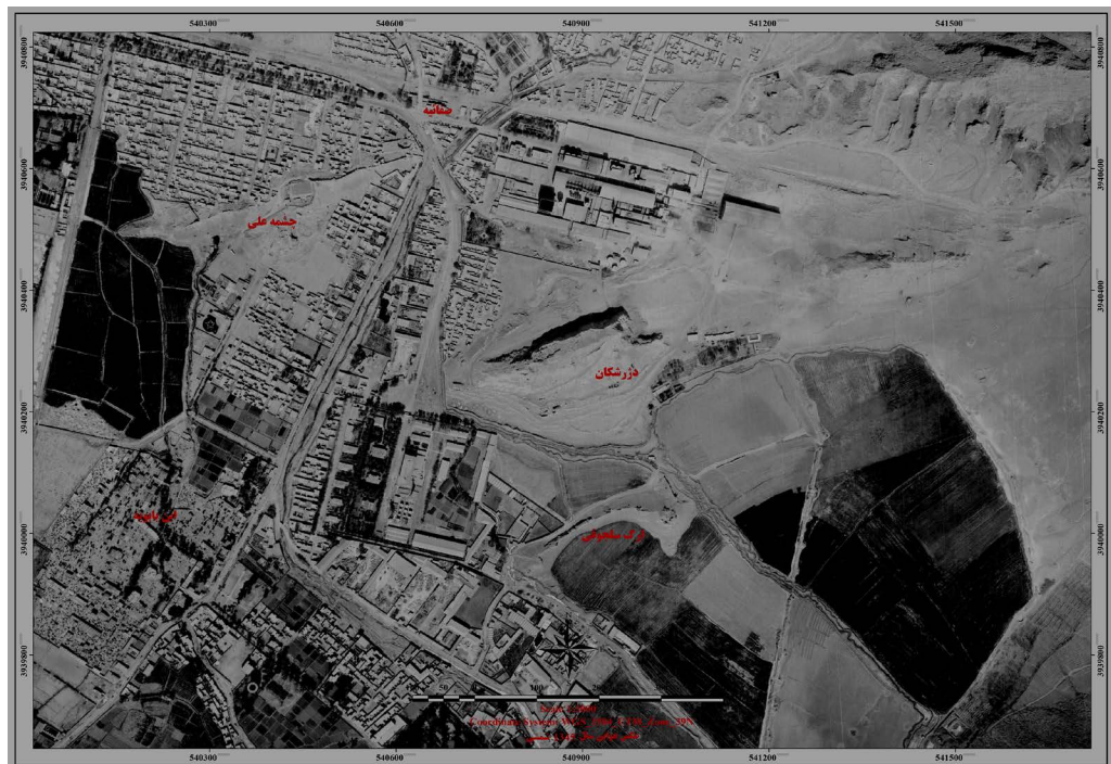
تصویر ۲۹: عکس هوایی از تخریب کوه سرسره در اثر کوه‌بری کارخانه سیمان در ۱۳۴۵ ه.ش. (سازمان نقشه‌برداری ایران).
