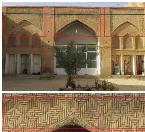
تصاویر ۱۵: بخش بالا تزئینات آجری طاق‌ها، بخش پایین طرح تزئین آجری پیشانی طاق‌ها، نقش سرزیر، سربالا (نگارندگان، ۱۴۰۲). Fig. 15: Upper part of the brick decorations of the arches, lower part of the brick decoration design of the arches' front, the pattern of the bottom, the top (Authors, 2023).
