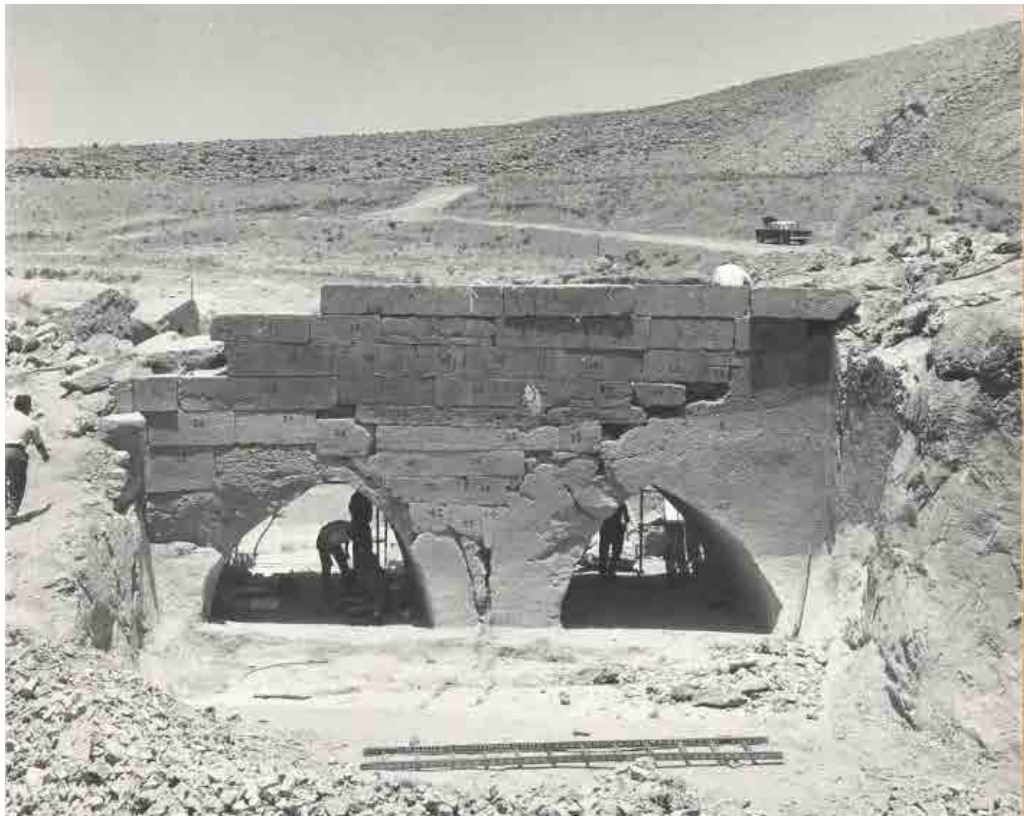
شکل ۲۰. سازه معماری بند دختر در حال انتقال به پایین دست (ملکزاده، ۱۳۹۳: ۱۴۶؛ تصویر ۷).
