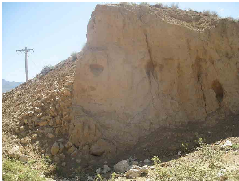
شکل ۱۹. هسته رسی و پوسته لاشه سنگی بند تنگ آسیاب (کریمی و زارعی، ۱۳۹۶: ۱۱۰؛ شکل ۷).
