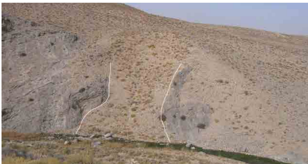
شکل ۳۴. برش دامنه سنگی کوه برای چفت کردن هسته رسی درون بافت سنگی کوه-بند دیدگان (کرمی، ۱۳۹۹). Fig. 34. Cutting the mountain stone domain to fasten the clay core inside the stone texture of Mount-Band Didegan (Karami, 2019).
