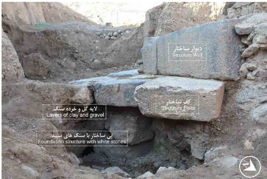
شکل ۳۹. ساختار معماری درون هسته سد دیدگان با روش خشکه چینی (کرمی، ۱۳۹۹). Fig. 39. The architectural structure inside the core of Didegan Dam by dry-picking method (Karami, 2019).
