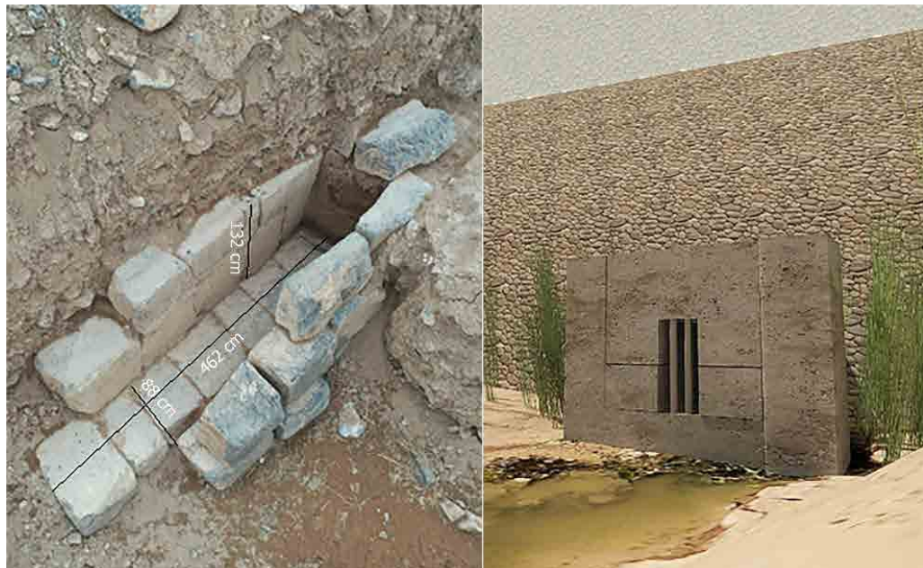
شکل ۶. وضعیت موجود ورودی سازه آبراه و تصویر بازسازی شده آن در هنگام آبادانی سد (مفتاح‌پور و همکاران، ۱۴۰۰).
