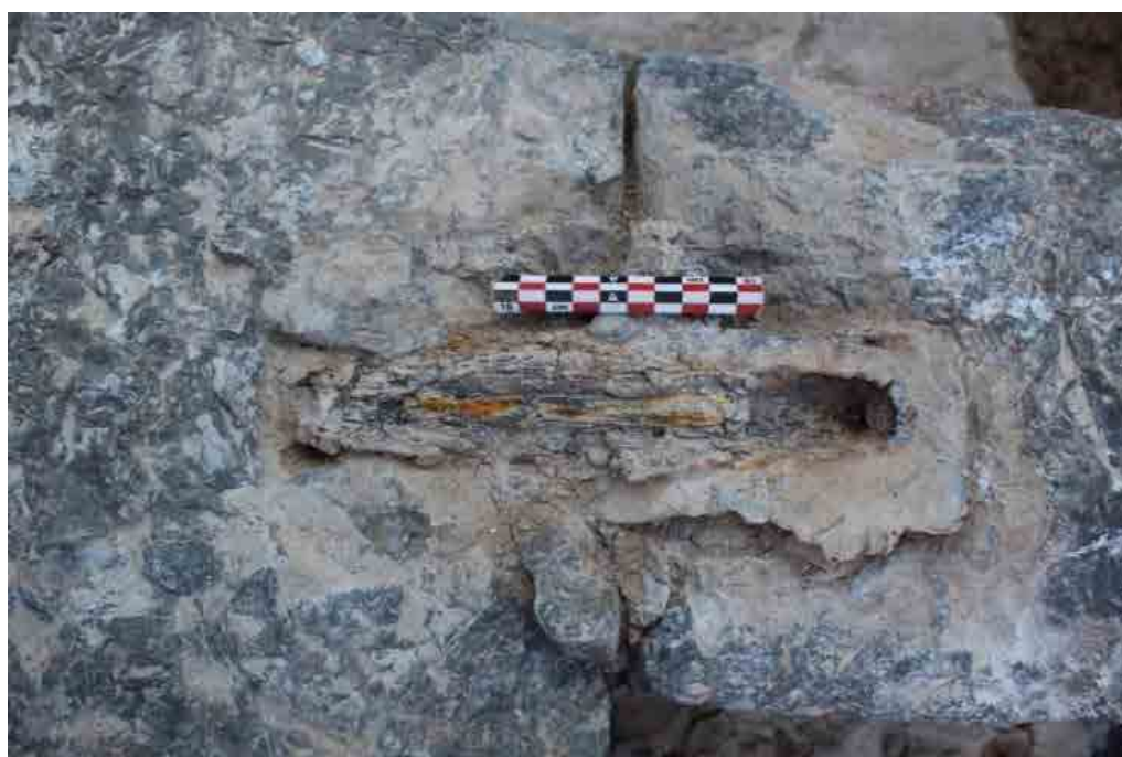
شکل ۳۸. گیره سالم آهنی با پوشش سربی به‌کار رفته در سازه معماری درون هسته سد دیدگان (کرمی، ۱۳۹۹).
