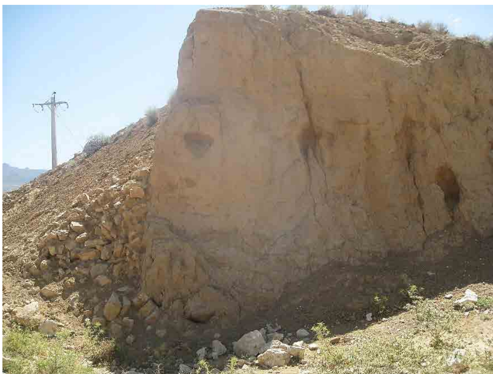
شکل ۱۹. هسته رسی و پوسته لاشه سنگی بند تنگ آسیاب (کرمی و زارعی، ۱۳۹۶: ۱۱۰؛ شکل ۷).
