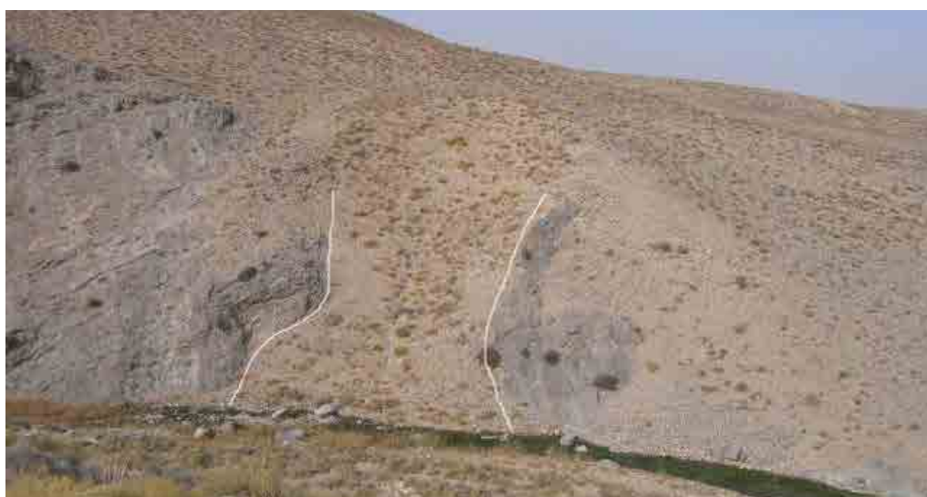
شکل ۳۴. برش دامنه سنگی کوه برای چفت کردن هسته رسی درون بافت سنگی کوه-بند دیدگان (کرمی، ۱۳۹۹). Fig. 34. Cutting the mountain stone domain to fasten the clay core inside the stone texture of Mount-Band Didegan (Karami, 2019).
