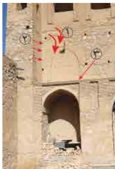
تصویر ۱۳: نمایش شماتیک کنش چرخش دیوار و واکنش برج و کمر بند الحاقی. ۱- محل چرخش دیوار، ۲- نیروی وارده برج به بخش آسیب دیده، ۳- کمر بند الحاقی برای جلوگیری از چرخش بیشتر بنا (نگارندگان، ۱۳۹۵).
