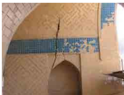
تصویر ۱۷: ترک عمیق در بخش فوقانی نمای داخلی جبهه شرقی (نگارندگان، ۱۳۹۵). Fig. 17: A Deep Crack in the Upper Part of the Inner East Elevation (Authors, 2016).
