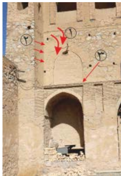
تصویر ۱۳: نمایش شماتیک کنش چرخش دیوار و واکنش برج و کمر بند الحاقی. ۱- محل چرخش دیوار، ۲- نیروی وارده برج به بخش آسیب دیده، ۳- کمر بند الحاقی برای جلوگیری از چرخش بیشتر بنا (نگارندگان، ۱۳۹۵). Fig. 13: Schematic Representation of the Wall Rotation & the Response of Additional Tower and Belt. 1- The Rotation Position of the Wall, 2- The Force of the Tower on the Damaged Part, 3- Additional Belt to Prevent the Building From Further Rotating (Authors, 2016).
