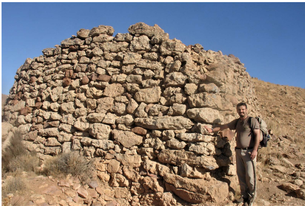
تصویر ۳: بخشی از استحکامات دفاعی قلعه نویافته باری در شمال دشت ارومیه (نگارندگان، ۱۳۹۷). Fig. 3: A part of the defense fortifications of Bari Castle in the north of Urmia Plain (Authors, 2017).
