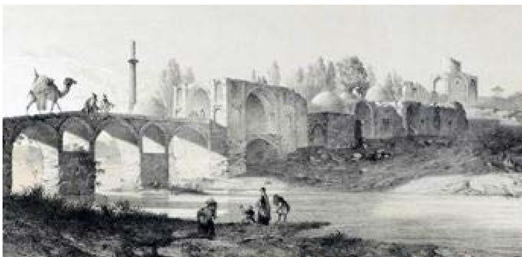
شکل ۱: شمایی از پل شهرستان و عمارت آن در سده ۱۹ م. اثر فلاندن (فلاندن، ۱۳۹۲: ۲۲۱). Fig. 1: A view of the Pol-e Shahrestan and its structure in the 19 th century (Flandin, 1392: 221).
