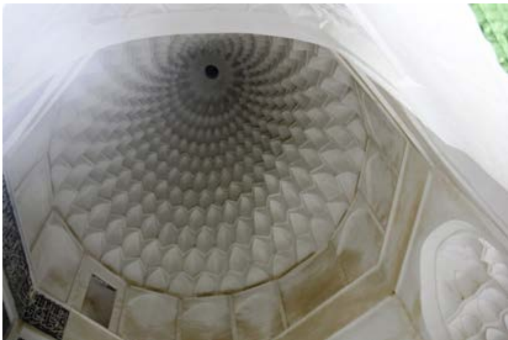
تصویر ۵: مقرنس گچی نمای داخلی گنبدخانه میرمحمد حنفی (نگارندگان، ۱۳۹۴). Fig. 5: Chalky muqarnas of the interior elevation of the dome chamber of Mir Muhammad Hanafi (Authors, 2015).
