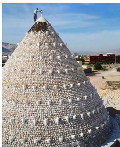
تصویر ۹. قرار دادن کاکل برکه پس از بازسازی گنبد (عکس از: هادی صدیقی).
