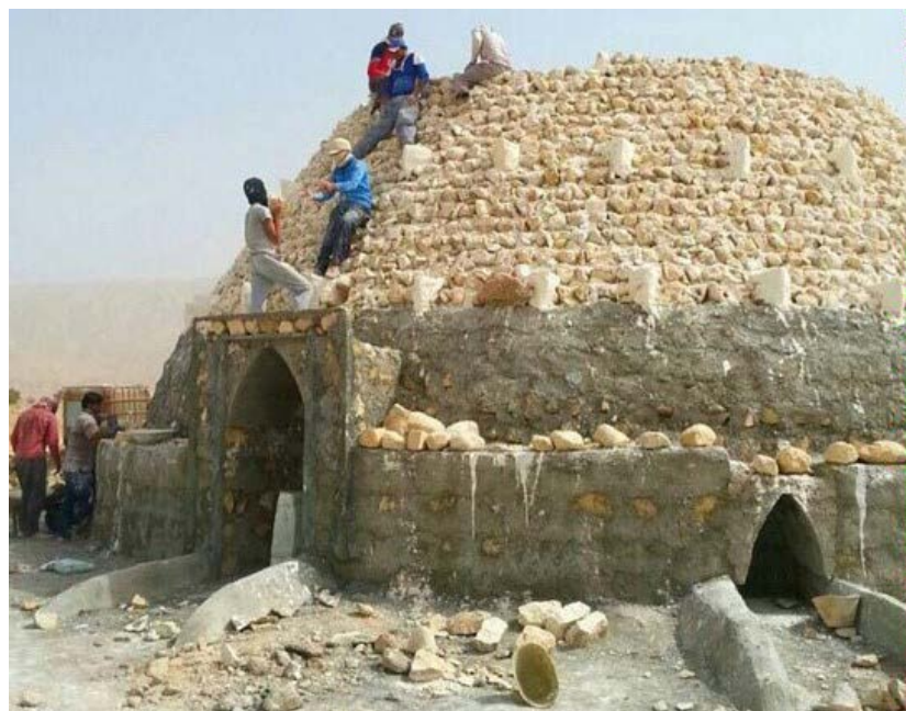
تصویر ۱۸. ساخت برکه جدید به عنوان یک سنت دیرینه (نگارنده، ۱۴۰۰).
