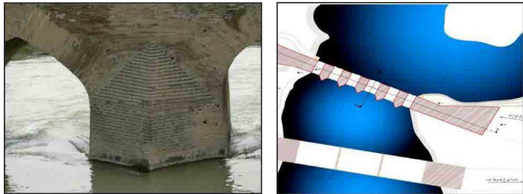
تصویر ۱۴. نقشه پل چالانچولان، و موج‌شکن مثلثی به‌کار رفته در پایه‌های این پل (صفایی‌زاده، ۱۳۹۱: ۲۲۲).
