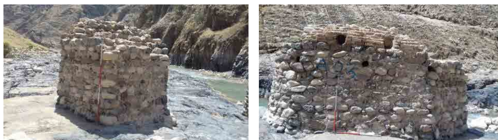
تصویر ۱۳. دومیورد از پایه‌های پل شماره ۳ نومکول، دید از شرق (نگارنده، ۱۳۹۸).
