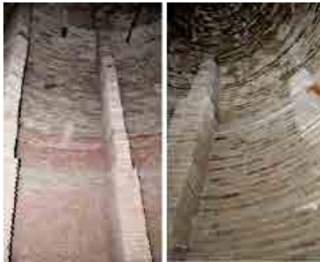
تصویر ۹. خشخاشی‌های آجری میان دو پوسته گنبد بزرگ آرامگاه درب امام (Safaeipour, et al., 2011: fig.8). Fig. 9. Stiffeners of the Darb-e Imam tomb's dome (Safaeipour, et al., 2011: fig. 8).
