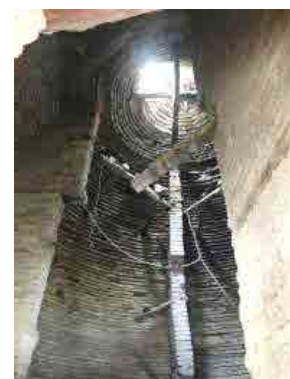
تصویر ۶. خشخاشی‌های آجری بین دو پوسته گنبد فیروزشاهی (نگارندگان، ۱۴۰۰).
