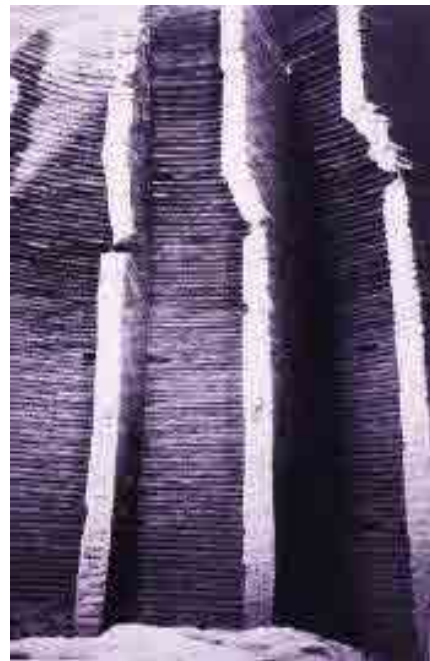
تصویر ۴. خشخاشی‌های میان دو پوسته گنبد آرامگاه گوهرشاد (O'kane, 1987: fig. 14-15).
