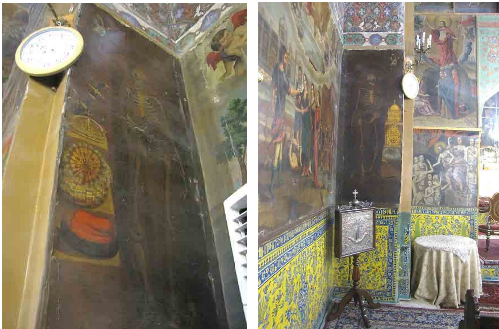
تصویر ۸. دیوارنگارهای بوم‌پارچه با موضوع اسکلت در دو طرف دیواره شرقی کلیسای مریم اصفهان (نگارندگان، ۱۴۰۰).
