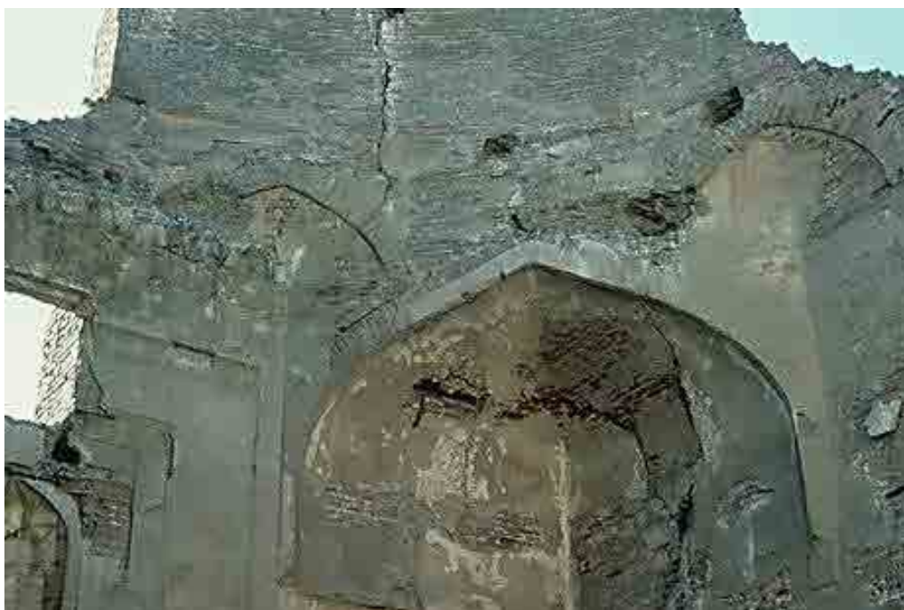
تصویر ۱۰. فضای داخل شبستان مسجد و نحوه تبدیل اضلاع به گنبد (نگارنده، ۱۳۹۳).
