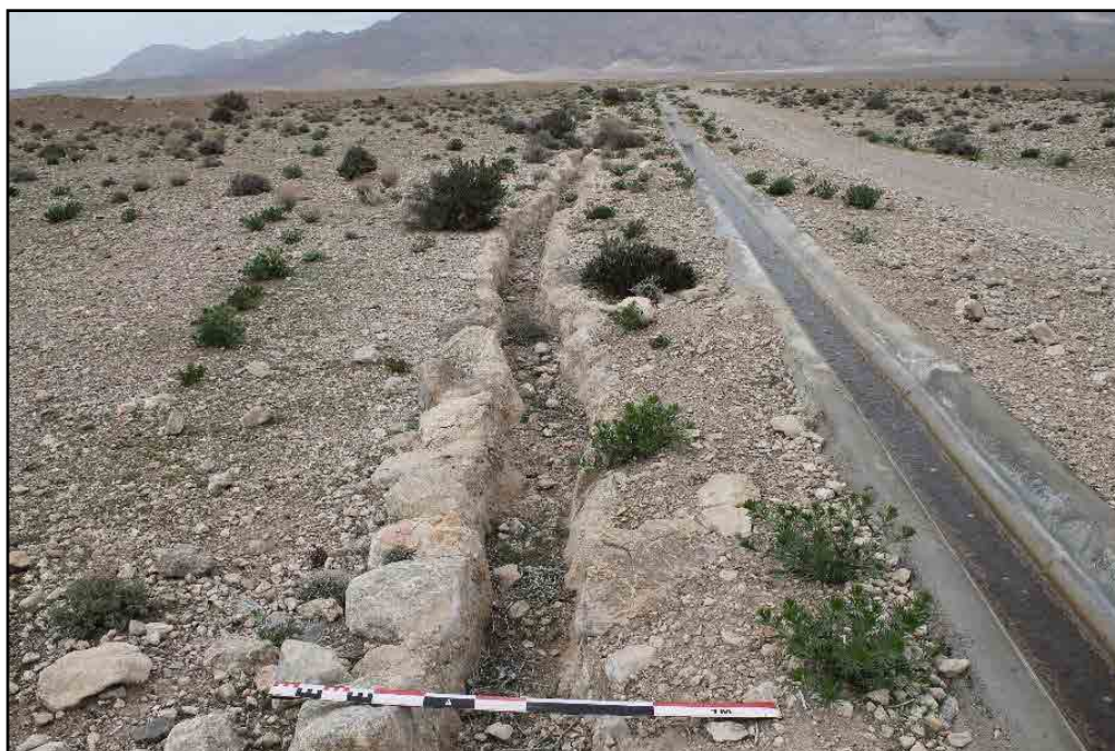
تصویر ۸: مسیر نهر قدیمی و جدید قنات میبد در کنار هم (نگارندگان ۱۳۹۶). Fig. 8: The route of the old and new Meybod Qanats side by side (Authors, 2017).
