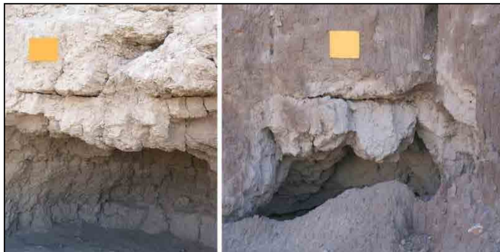
شکل ۱۳: آسیب‌هایی مانند آب‌شستگی‌ها در دستکندهای ارگ بام (نگارنده اول، ۱۳۹۵).
