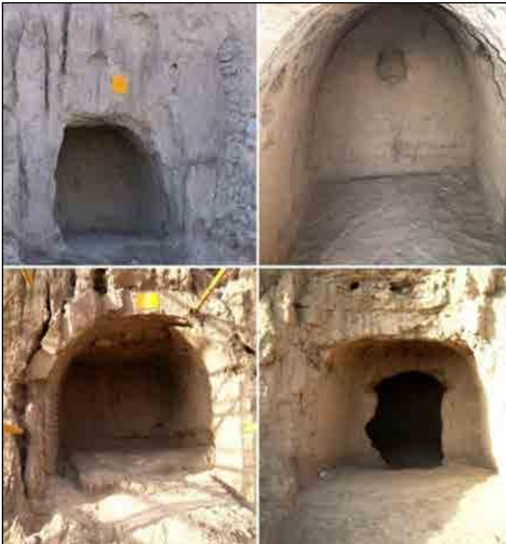
شکل ۷: دستکند در بافت متراکم ولایه چینه‌ای حصار (نگارنده اول، ۱۳۹۵).
