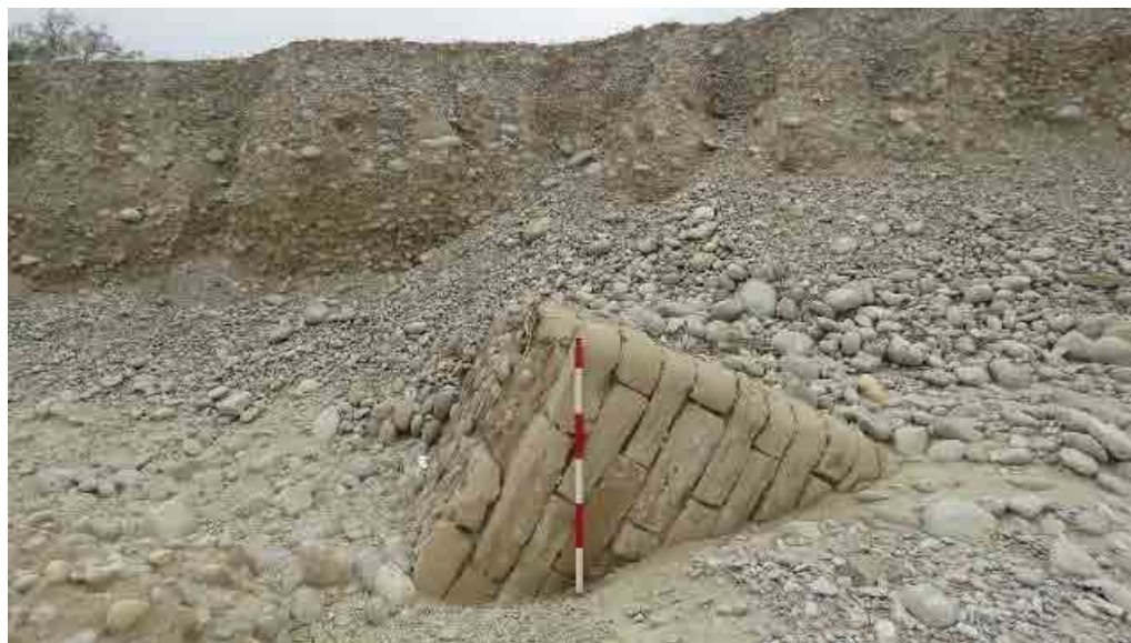
تصویر ۸: نمایی از چیدمان سنگ‌های روکار سازه (نگارنده، ۱۳۹۵).
