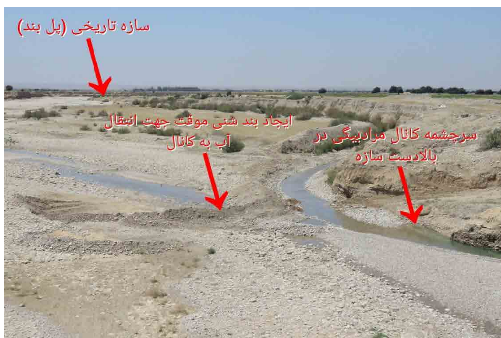
تصویر ۱۹: موقعیت سازه تاریخی پل بند رودخانه اعلای نسبت به سرچشمه کانال حکمی یا مرادیگی (نگارنده، ۱۴۰۴). Fig. 19: The location of the historical structure of the A'ala River Dam Bridge in relation to the source of the Hakami or Moradbeigi Channel (Author, 2025).
