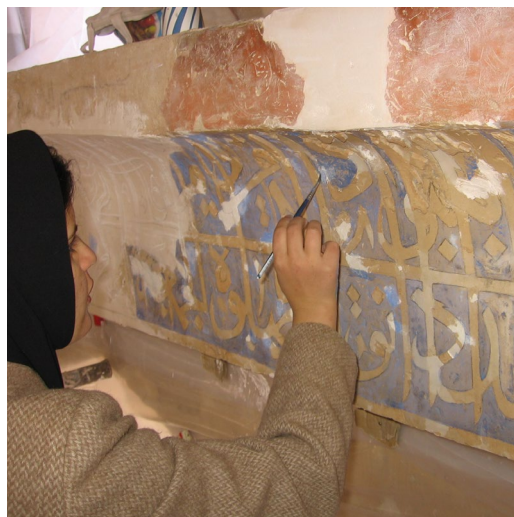
شکل ۴۱. موزون سازی رنگی بخش های بازسازی شده کتیبه گچبری (عکس از نگارنده)
