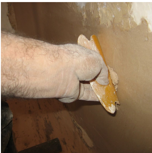
شکل ۴۰. پر کردن و بازسازی بخش های کمبود بزرگ کتیبه گچبری با ملات گچ اشکال چپ و راست (عکس از نگارنده)
