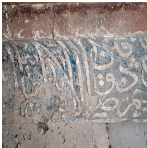
شکل ۲۸. راست: دور نمایی از ریزش کل کتیبه گچبری به همراه بستر زیرین کار از سطح بدنه بنا؛ چپ: نمایی نزدیک از ریزش کل کتیبه گچبری به همراه بستر (عکس از نگارنده)
