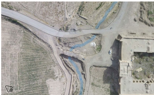
شکل ۲. موقعیت پل بر روی رودخانه (Esfanjari, 2017)
