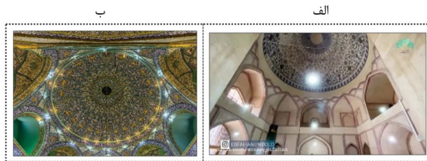
شکل ۱۳. کاربندی در تاق کوچک، الف) سکنج ساده با کاربندی، مسجدساروتقی (ب) ترمیمه فیلیوش با کاربندی مسجد امام تهران، (تصویر: دانشنامه تاریخ، معماری و شهرسازی ایران)
