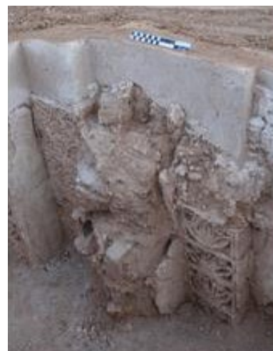
شکل ۱۰. مراحل حفاظت از بخش فوقانی دیواره، شامل پاک‌سازی خاک‌های انباشته، اجرای یک ردیف آجر پشتیبان با استفاده از ملات گچ نیم‌کوب و حفاظت از باقی‌مانده آرایه‌های گچ‌بری
