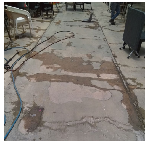
شکل ۵. اجرای پوشش مقاوم سیمانی ضد آب بر روی سطح بتنی افقی، تصویر سمت راست قبل از اجرا و تصویر سمت چپ بعد از اجرا Figure 5. Application of Water-Resistant Cement Plaster on a horizontal concrete surface (right: before application, left: after application)
