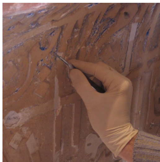
شکل ۳۵. پاکسازی گچبری به شیوه مکانیکی با تیغ بیستوری (عکس از نگارنده)
