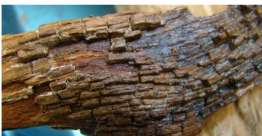
شکل ۱۵. بخشی از تیر چوبی کشف شده و استحکام بخشی آن Figure 15. Section of the discovered wooden beam and its reinforcement
