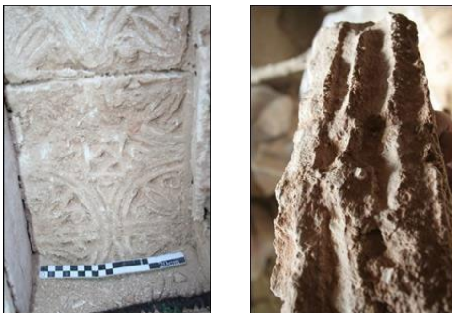
شکل ۷. چپ: گچ‌بری‌های باقی‌مانده بر روی دیواره در محوطه گچ گنبد شرقی، اجرا شده به روش قالب‌گیری، همراه با درزهای میان دو قالب. راست: شیارهای ایجاد شده در پشت قطعه‌ای از گچ‌بری‌های قالبی، با هدف افزایش گیرش در هنگام نصب. Figure 7. Left: Remaining stucco decorations on the wall surface in the eastern Gach Gonbad site, executed using moulding techniques, with visible seams between two moulds. Right: Grooves carved into the back of a moulded stucco fragment to enhance adhesion during installation.
