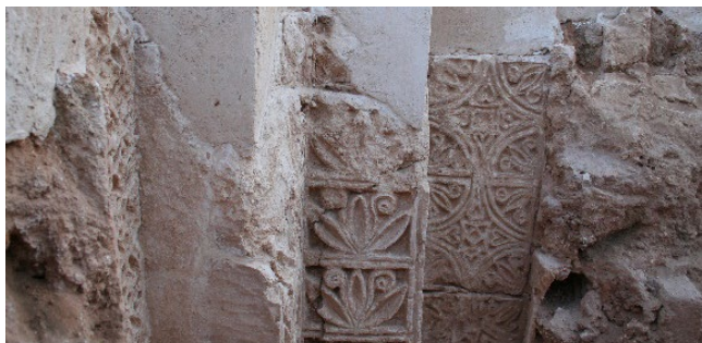
شکل ۱۱. تفکیک مرز میان لایه گچ حفاظتی و سطح گچ‌بری اصلی از طریق عقب‌نشستن و زیره‌سازی اندود حفاظتی.
