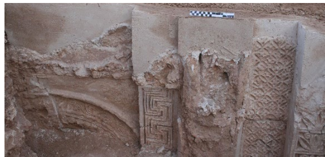
شکل ۱۱. تفکیک مرز میان لایه گچ حفاظتی و سطح گچ‌بری اصلی از طریق عقب‌نشستن و زیره‌سازی اندود حفاظتی.
