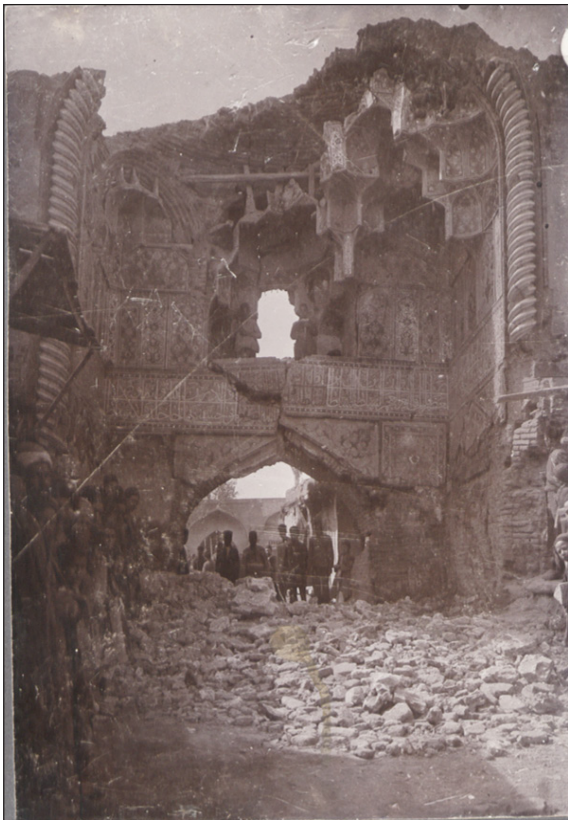
تصویر ۲. سردر عالی قاپو در حال تخریب (مأخذ: آلبوم‌خانه کاخ گلستان).
