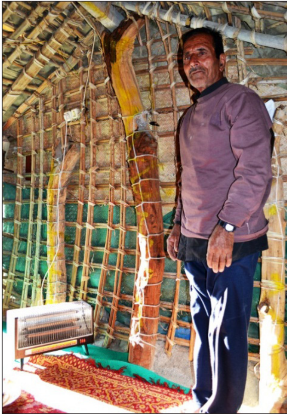
تصویر ۵. کاربرد چوب (سرخدار) جگ به عنوان ستون در کپر در درگوان بشکرد (شخص حاضر در تصویر جناب آقای علی کمالی، راهنمای نگارنده در درگوان) (عکس از: نویسنده).
