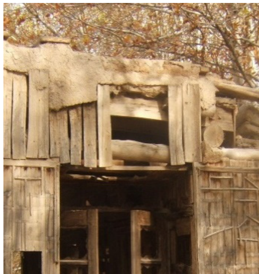
تصویر ۳۱. تخته کوبی و اجرای اندود کاهگل بر لبه ضلع جنوبی و شمالی بام (مأخذ: هلاکوئی، ۱۳۹۳).
