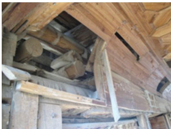
تصویر ۲۷. گلوبی زیرسقف (چوب‌های منحنی و تخته کوبی روی آنها) (مأخذ: هلاکوئی، ۱۳۹۳).
