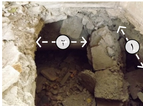
تصویر ۱۲. شواهد تیرهای عبور کرده از زیر دیوار اتاق‌ها (عکس از: نویسندگان).
