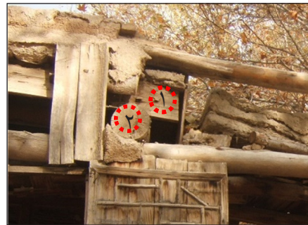
تصویر ۲۵ و طرح ۲۰. قرارگیری تیره‌های سقف اتاق بر روی تیری به قطر ۱۷ سانتی‌متر (مأخذ: هلاکوئی، ۱۳۹۳).
