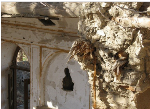
تصویر ۱۵ و نقشه ۱۳. اجرای کلاف‌های سر دیوار و تیرریزی فضای خدماتی (ترسیم و عکس از: نویسندگان).
