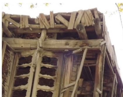
تصویر ۲۸ و ۲۹ و طرح ۲۴. تخته‌کوبی دورتادور تیرهای سقف اتاق و اندود کاهگل روی آن (مأخذ: هلاکوئی، ۱۳۹۳).
