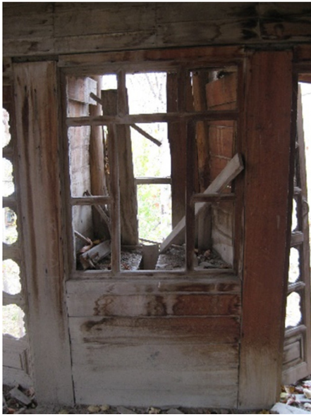
تصویر ۳۵ و طرح ۳۶. اجرای چهار چوب پنجره در قاب ایجادشده (مأخذ: هلاکوئی، ۱۳۹۳).
