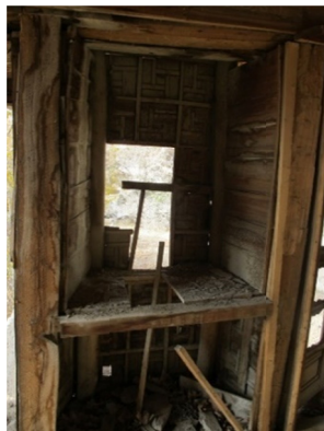
تصویر ۳۳ و طرح ۳۴. شکاف‌های ایجاد شده در ستون‌ها و اجرای تخته در آن‌ها (مأخذ: هلاکوئی، ۱۳۹۳).
