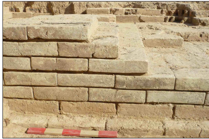
تصویر ۱۶. ترانشه ۳، نمای دیوار غربی، آجرهای لعابدار (عکس از: هیئت مشترک ایرانی ایتالیایی).
