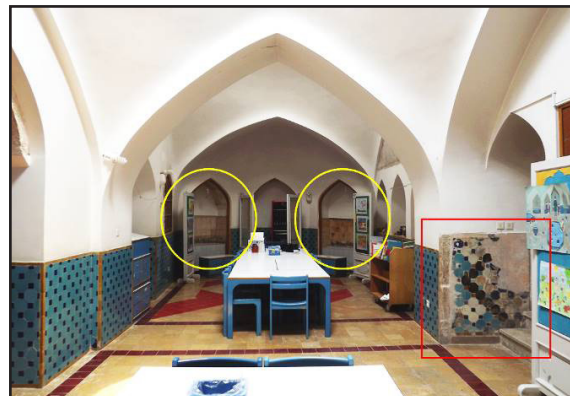
تصویر ۱۳. گرمخانه حمام وزیر، محل قرارگیری کاشی‌های کوباچه و کاشی‌های یکرنگ در تصویر مشخص شده است (عکس از: نگارندگان).
