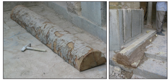
اتصال پاشنه به زمین با ملات گچ و خاک
