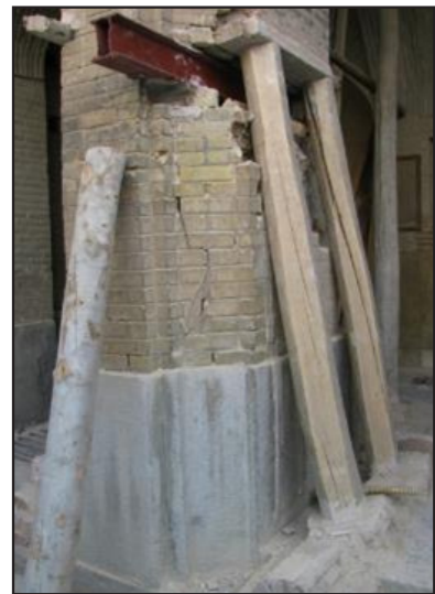
تصویر ۶. نصب تیر آهن به عنوان سازه کمکی (عکس از: نگارنده).
