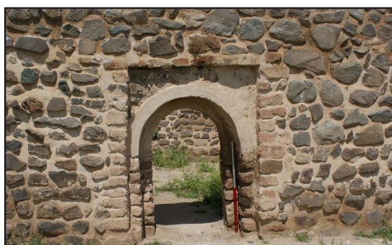
تصویر ۱۵. آجرهای بزرگ محوطه تشویر استفاده‌شده در درگاه بنای آرامگاهی تشویر (عکس از: نگارنده).
