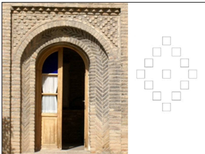
تصویر ۸. کاربرد خورون چینی در خانه آخوند ابو (عکس از: میرزاوند، ۱۳۹۴).
