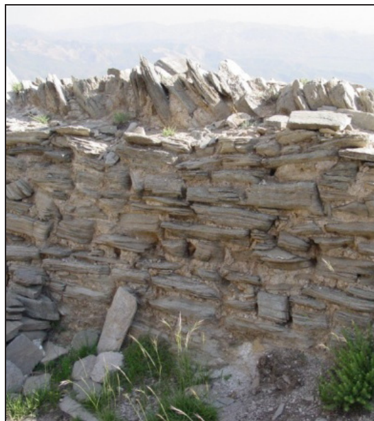
تصویر ۸. نمای یکی از دیوارهای تخت بلقیس در نزدیکی تکاب که در ساخت آن از سنگ‌های لاشه کشیده استفاده شده است (مأخذ: نگارنده).
