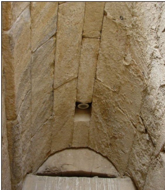
تصویر ۳. تاق آهنگ شیب‌دار پلکان ورودی معبد آناهیتا در بیشاپور (مأخذ: نگارنده).
