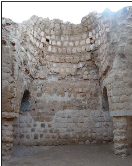
تصویر ۱۰. کاخ سروستان، نمایی از عناصر معماری متشکل از سنگ‌های قواره شده (مأخذ: نگارنده).
