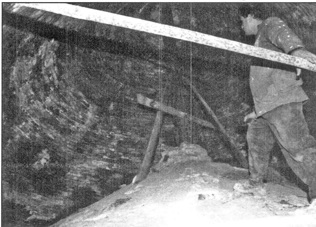
(عکس شماره ۶۷) عکس از ساختار چوبی بین دو پوسته گنبد و یکی از کلافهای فلزی شخصی که در عکس دیده می‌شود استاد حیدر یکی از استادان دلاور تیریزی است. ۱۳۷۵
