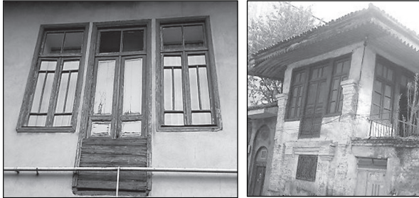
تصویر ۷- بازشویهای چلیپایی (پاچلاقی) بالا: ماسوله (مأخذ: پایگاه ماسوله)
