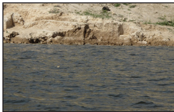
تصویر ۱۵: در این تصویر بالا آمدن آب تا پای دیوار شمالی بنا (دیوار دارای طاقچه‌های سه گانه) مشاهده می‌شود (عکس از: نگارنده).
