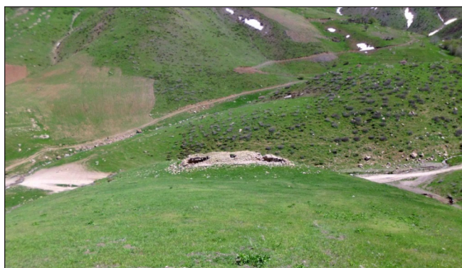
تصویر ۳. موقعیت پشت بنای کورتک. جهت عبور بهمن بنا هم‌سطح با سطح زمین ساخته شده است (عکس از: نویسندگان).
