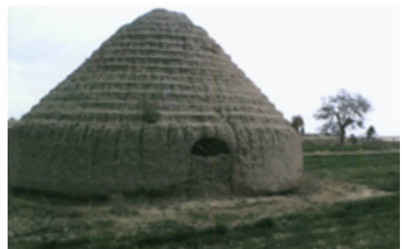
تصویر ۱۳. گنبد پلکانی یخچال شه‌سفید گرمسار (مأخذ: سازمان میراث فرهنگی، گردشگری و صنایع دستی).
