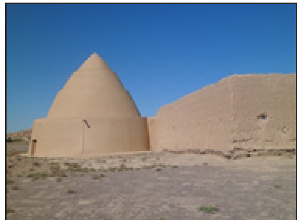
تصویر ۱۰. موقعیت قرارگیری گنبد یخچال بافران نائین نسبت به دیوار سایه‌انداز (عکس از: نگارندگان).
