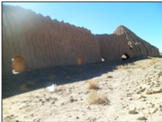
تصویر ۱۱. موقعیت قرارگیری گنبد یخچال لنگر کرمان نسبت به دیوار سایه‌انداز و قرارگیری ورودی آن در سایه دیوار سایه‌انداز (عکس از: نگارندگان).
