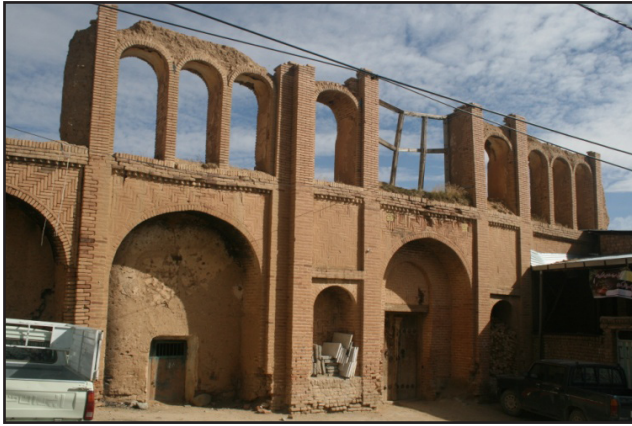
تصویر ۷. خانه رحیم خان، نمای ورودی (مأخذ: پرونده ثبت اثر).
