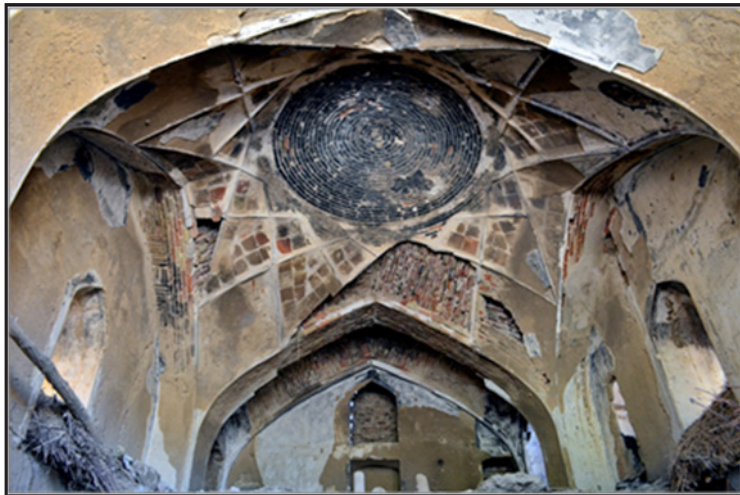
تصویر ۸. کاربندی اخترى سقف حوض خانه کوشک عباس آباد نطنز (عکس از: نگارندگان).
