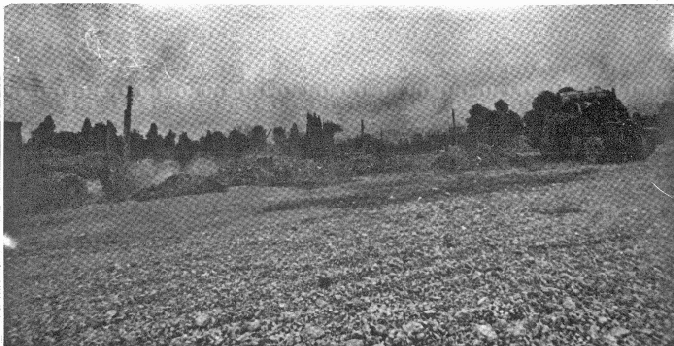
پس از تخریب کامل
