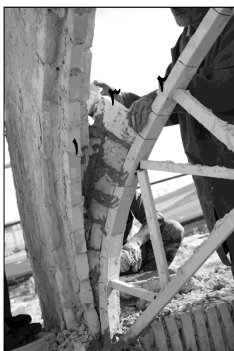
تصویر ۱۱. سمت راست: جاگذاری قالب برای اجرای باریکه‌طاق دوم؛ سمت میانی و چپ: شروع رج اول باریکه‌طاق دوم در کنار رج اول باریکه‌طاق اول (دید از دو جهت مختلف)؛ سمت چپ پایین: ادامه اجرای رج اول باریکه‌طاق دوم (همان‌طور که در تصویر مشاهده می‌شود پس از برداشتن قالب، رج‌های اول هر دو باریکه‌طاق در کنار هم قرار گرفته و از یک نقطه شروع می‌شوند و در نهایت به عنوان خطوط هندسه کاربردی از زیر دیده می‌شوند). کارگاه کارآموزی مرمت، دانشگاه بین‌المللی امام خمینی قزوین، بهار و تابستان ۱۳۸۷.
