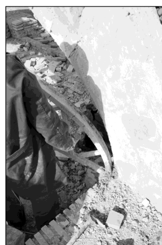
تصویر ۱۰. بازسازی نیم‌کار ایوان ورودی شترخان سرای وزیر قزوین به روش اول ۱. سطح درازای (نره) آجر که به عنوان خطوط هندسه کاربردی از زیر دیده می‌شود (مأخذ: نگارنده).
