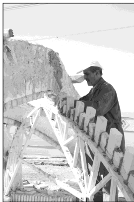
تصویر ۸. سمت راست: جاگذاری قالب در لبه جرز؛ سمت میانی و چپ: اجرای رج اول با آجر نیمه (ابوالفضل شهردوست استادکار سنتی در حال اجرا). کارگاه کارآموزی مرمت، دانشگاه بین المللی امام خمینی قزوین، بهار و تابستان ۱۳۸۷ (مأخذ: نگارنده).
