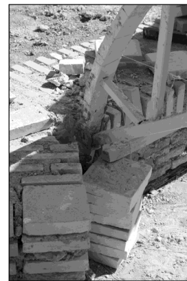
تصویر ۸. سمت راست: جاگذاری قالب در لبه جرز؛ سمت میانی و چپ: اجرای رج اول با آجر نیمه (ابوالفضل شهردوست استادکار سنتی در حال اجرا). کارگاه کارآموزی مرمت، دانشگاه بین المللی امام خمینی قزوین، بهار و تابستان ۱۳۸۷ (مأخذ: نگارنده).
