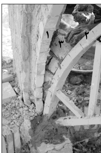
تصویر ۱۰. بازسازی نیم‌کار ایوان ورودی شترخان سرای وزیر قزوین به روش اول ۱. سطح درازای (نره) آجر که به عنوان خطوط هندسه کاربردی از زیر دیده می‌شود (مأخذ: نگارنده).
