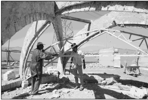
تصویر ۱. ساخت قالب با قوطی فلزی، به صورت دو قوس نیمه که با پیچ و مهر به یکدیگر متصل شده و به قوس کامل تبدیل شده اند. کارگاه کارآموزی مرمت، دانشگاه بین‌المللی امام خمینی قزوین، بهار و تابستان ۱۳۸۷ (مأخذ: نگارنده).
