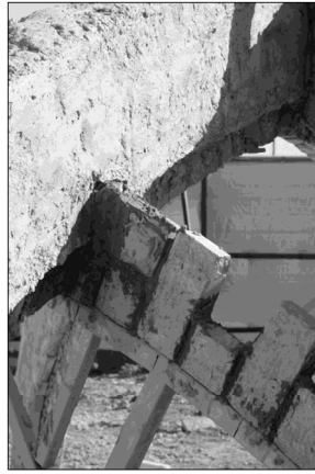
تصویر ۶. سمت راست، میانی، و چپ: محل تقاطع دو باریکه طاق؛ اتصال باریکه طاق جدید با ملات گچ و خاک به باریکه طاق پیشین (مأخذ: نگارنده).
