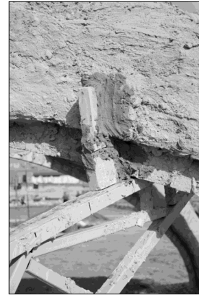
تصویر ۶. سمت راست، میانی، و چپ: محل تقاطع دو باریکه طاق؛ اتصال باریکه طاق جدید با ملات گچ و خاک به باریکه طاق پیشین (مأخذ: نگارنده).
