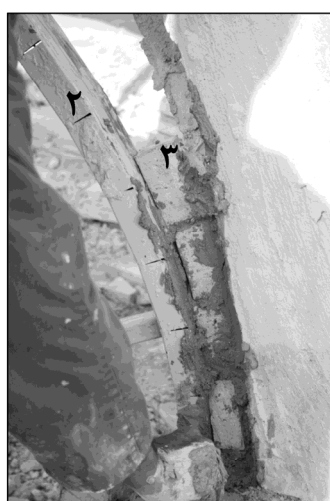
تصویر ۱۰. بازسازی نیم‌کار ایوان ورودی شترخان سرای وزیر قزوین به روش اول ۱. سطح درازای (نره) آجر که به عنوان خطوط هندسه کاربردی از زیر دیده می‌شود (مأخذ: نگارنده).
