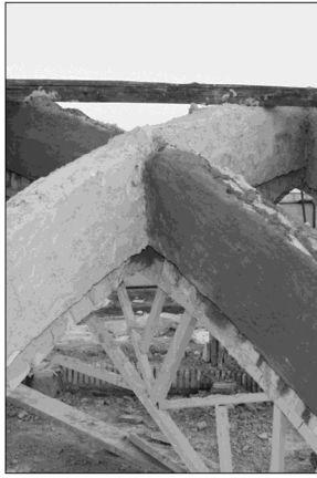
تصویر ۶. سمت راست، میانی، و چپ: محل تقاطع دو باریکه طاق؛ اتصال باریکه طاق جدید با ملات گچ و خاک به باریکه طاق پیشین (مأخذ: نگارنده).
