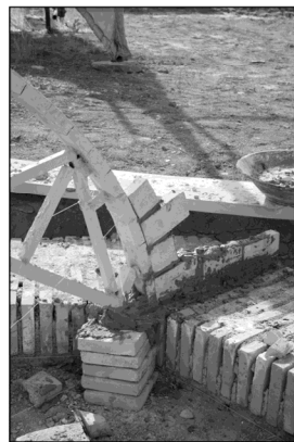
تصویر ۸. سمت راست: جاگذاری قالب در لبه جرز؛ سمت میانی و چپ: اجرای رج اول با آجر نیمه (ابوالفضل شهردوست استادکار سنتی در حال اجرا). کارگاه کارآموزی مرمت، دانشگاه بین المللی امام خمینی قزوین، بهار و تابستان ۱۳۸۷ (مأخذ: نگارنده).
