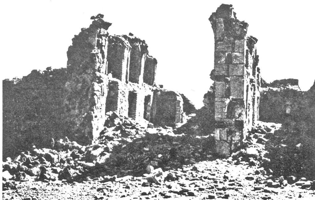
عکس ۱۱ شماره ۲- عباس آباد / سیاہکوه ، حرمسرا ، ایوان جنبه غربی
