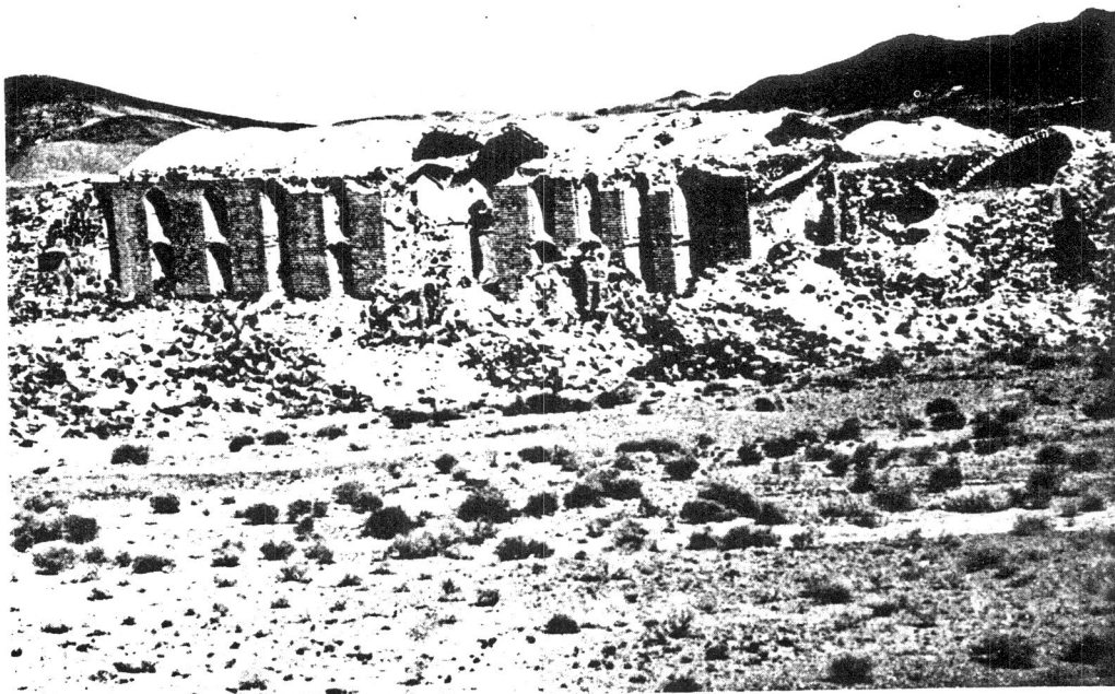
عکس ۴ شماره ۱- بنای سفیدآب - حرمسرا . دید از جنوب شرقی
